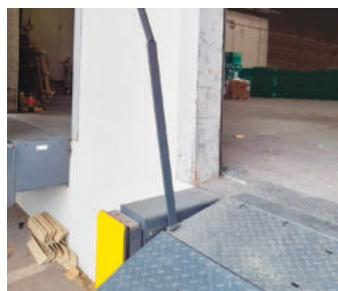
Mini rampe de chargement acier avec zone refuge 6 000 kg.
